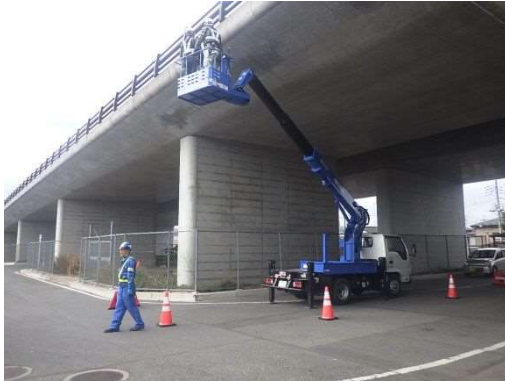
写真 3-1-1 定期点検のイメージ (高所作業車)
