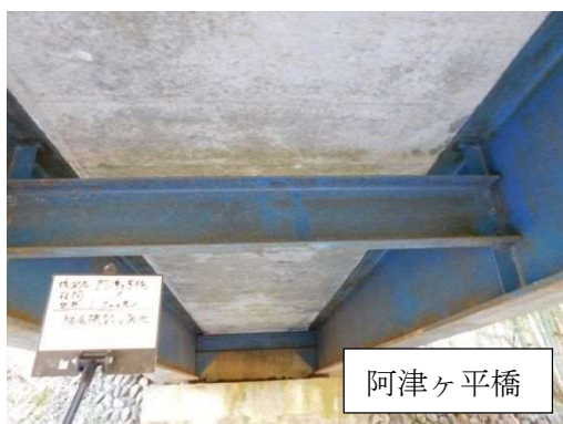
写真 4-2-27 防食機能の劣化(1)
