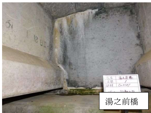
写真 4-2-35 漏水・遊離石灰
