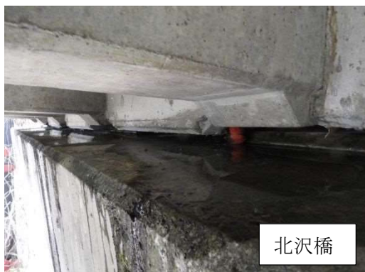
写真 4-2-47 漏水・滞水
