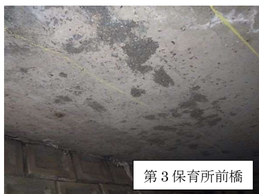
写真 4-2-19 床版ひびわれ
