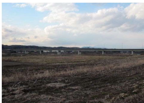
写真 1-1-1 八溝大橋（那珂川 橋長 383m）
