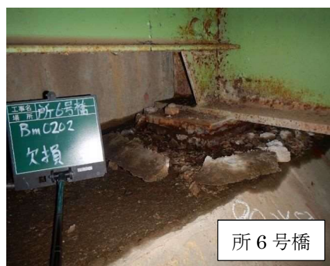
写真 4-2-44 変形・欠損
