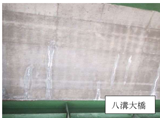
写真 4-2-15 漏水・遊離石灰
