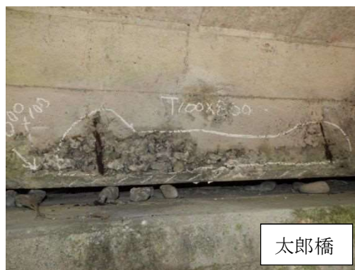
写真 4-2-30 剥離・鉄筋露出
