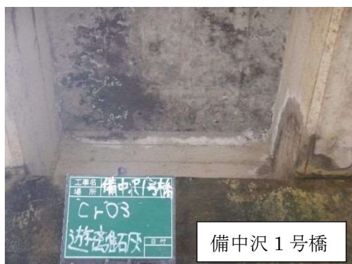
写真 4-2-31 漏水・遊離石灰
