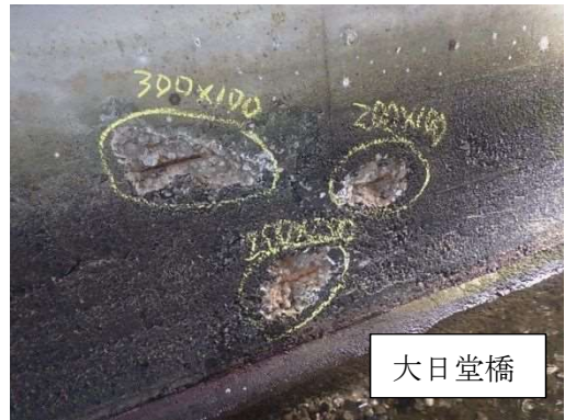
写真 4-2-38 剥離・鉄筋露出
