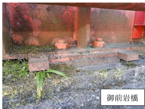
写真 4-2-42 防食機能の劣化
