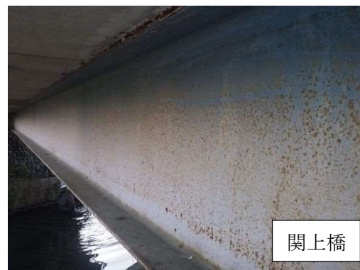
写真 4-2-4 防食機能の劣化
