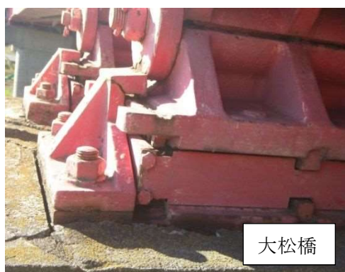
写真 4-2-43 支承部の機能障害
