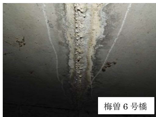
写真 4-2-18 漏水・遊離石灰
