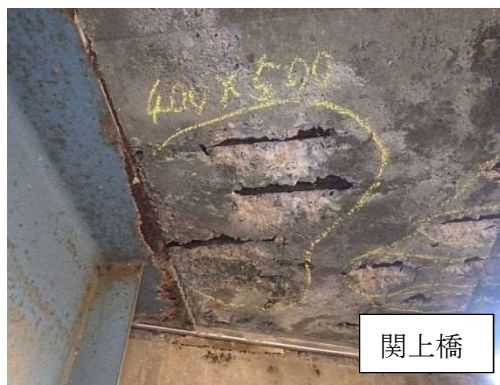
写真 4-2-14 剥離・鉄筋露出
