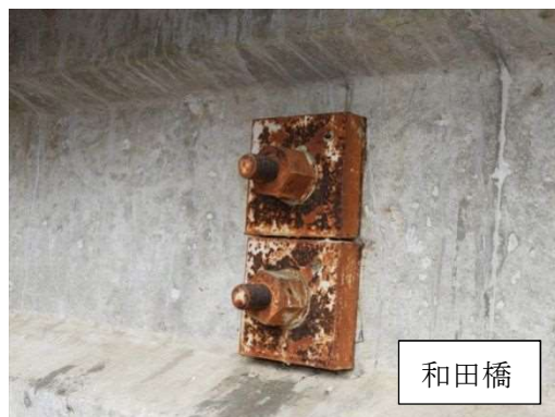
写真 4-2-36 定着部の異常
