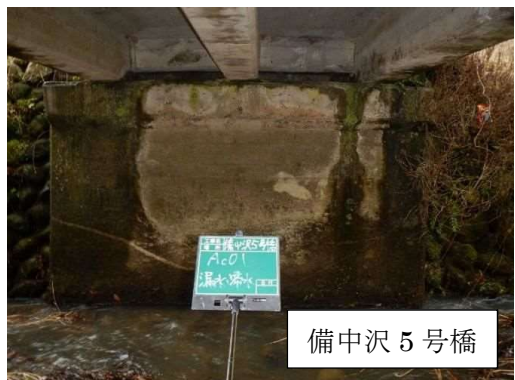
写真 4-2-40 漏水・滞水
