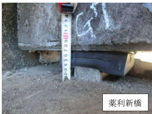
写真 4-2-45 支承部の機能障害
