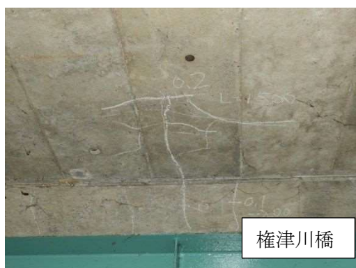
写真 4-2-16 床版ひびわれ
