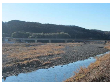
写真 1-1-2 浄法寺橋（箒川 橋長 218m）
