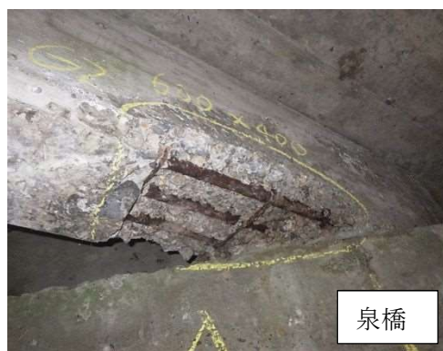
写真 4-2-6 剥離・鉄筋露出
