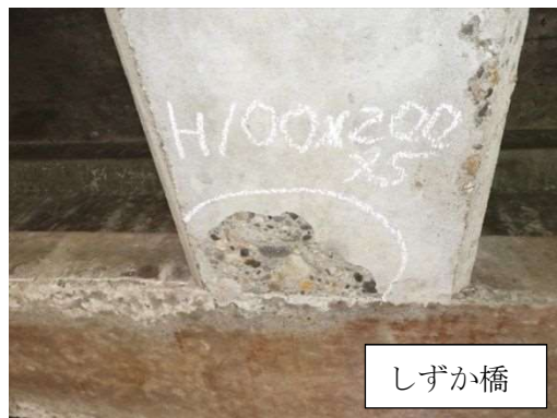
写真 4-2-34 剥離・鉄筋露出
