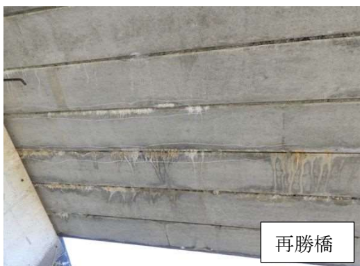
写真 4-2-23 漏水・遊離石灰(2)
