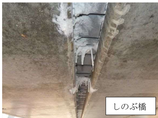
写真 4-2-22 漏水・遊離石灰(1)
