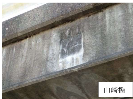
写真 4-2-12 漏水・遊離石灰
