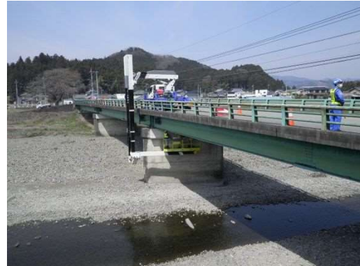
写真 3-1-2 定期点検のイメージ (橋梁点検車)
