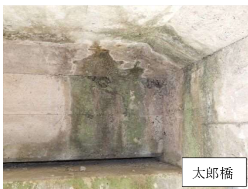
写真 4-2-32 漏水・滞水
