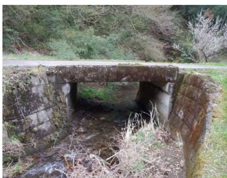
写真 1-1-4 萩の越路橋（樋川 橋長 4m）
