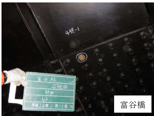
写真 4-2-3 ボルトの脱落
