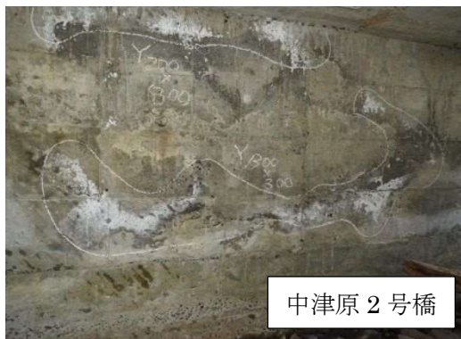
写真 4-2-39 漏水・遊離石灰
