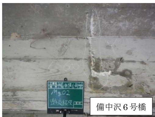
写真 4-2-7 漏水・遊離石灰
