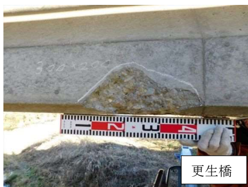
写真 4-2-11 剥離・鉄筋露出
