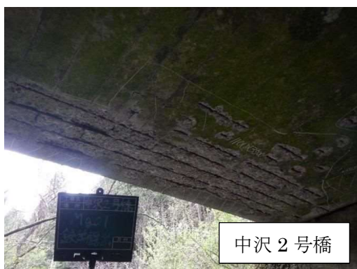
写真 4-2-17 剥離・鉄筋露出
