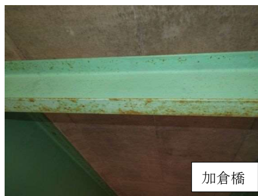
写真 4-2-28 防食機能の劣化(2)
