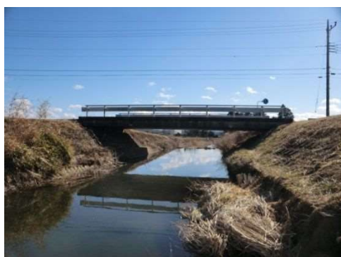
写真 1-1-3 山崎橋（権津川 橋長 16m）
