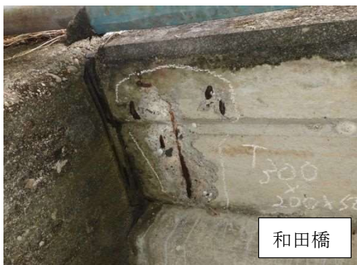
写真 4-2-21 剥離・鉄筋露出
