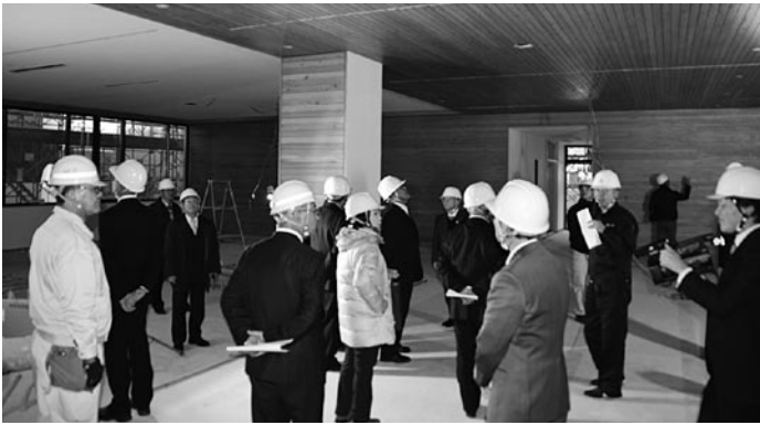
工事関係者から説明を聞く
