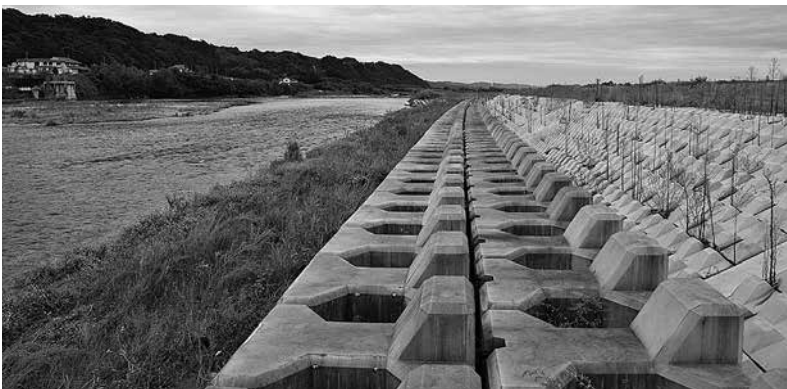
復旧工事が完了した那珂川右岸護岸施設
