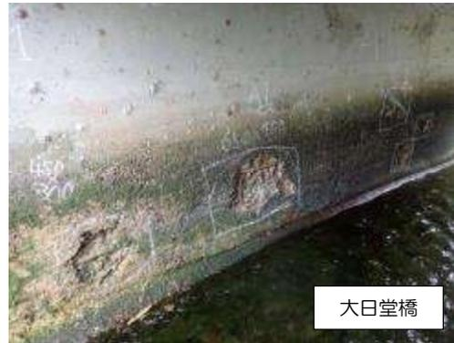
写真 3-3-38 剥離・鉄筋露出
