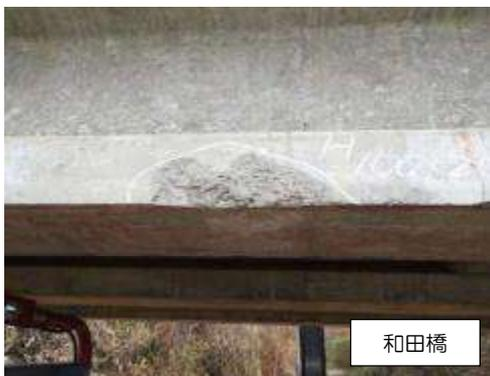
写真 3-3-11 剥離・鉄筋露出(1)
