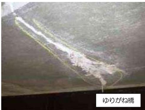
写真 3-3-15 漏水・遊離石灰
