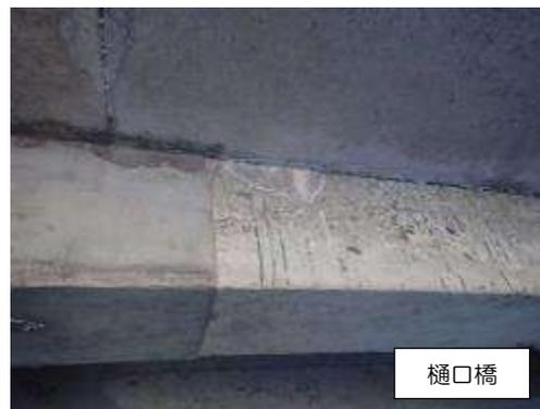
写真 3-3-8 漏水・遊離石灰
