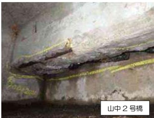
写真 3-3-31 剥離・鉄筋露出(2)
