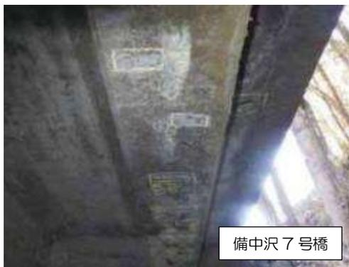
写真 3-3-7 剥離・鉄筋露出(2)
