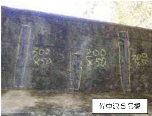
写真 3-3-17 剥離・鉄筋露出
