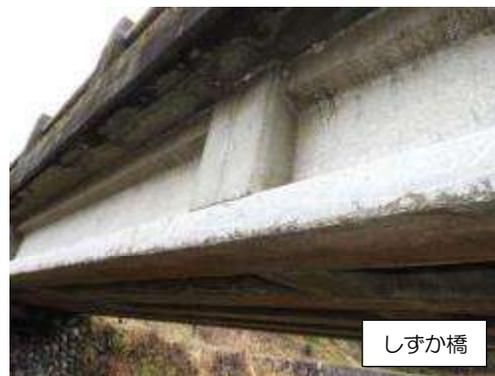
写真 3-3-12 剥離・鉄筋露出(2)
