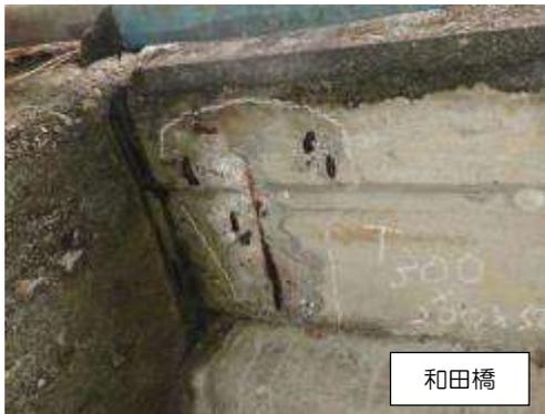
写真 3-3-21 剥離・鉄筋露出(1)
