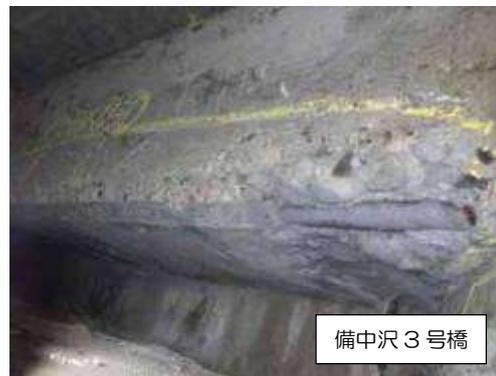
写真 3-3-30 剥離・鉄筋露出(1)
