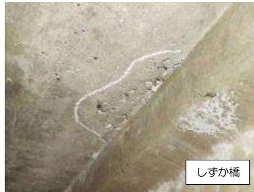
写真 3-3-22 剥離・鉄筋露出(2)
