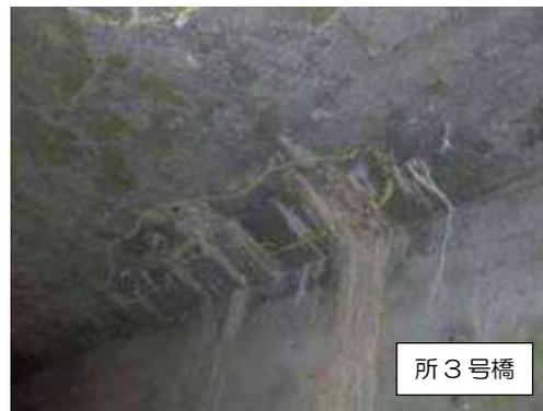
写真 3-3-18 漏水・遊離石灰
