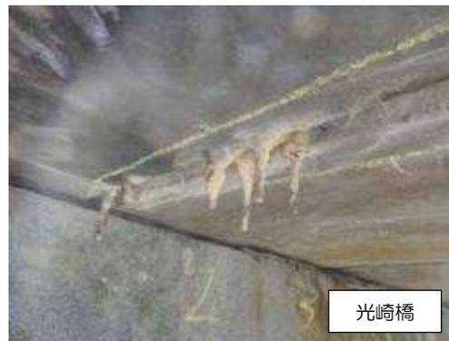
写真 3-3-24 漏水・遊離石灰(2)
