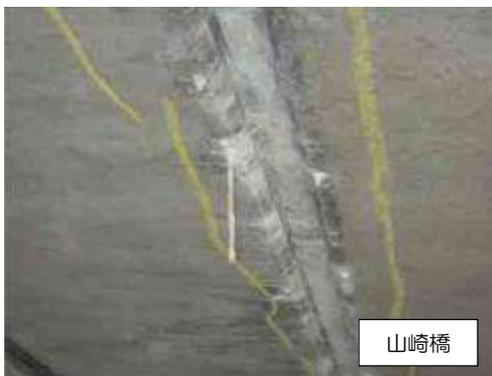
写真 3-3-23 漏水・遊離石灰(1)
