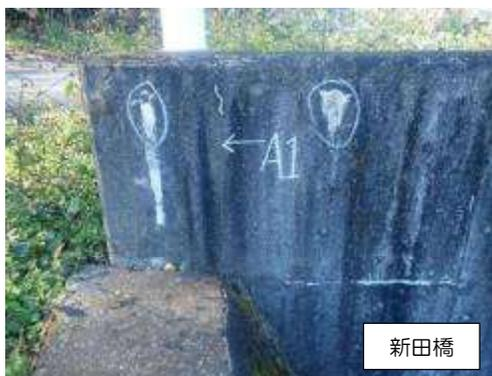
写真 3-3-39 漏水・遊離石灰
