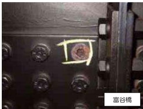
写真 3-3-3 ボルトの脱落
