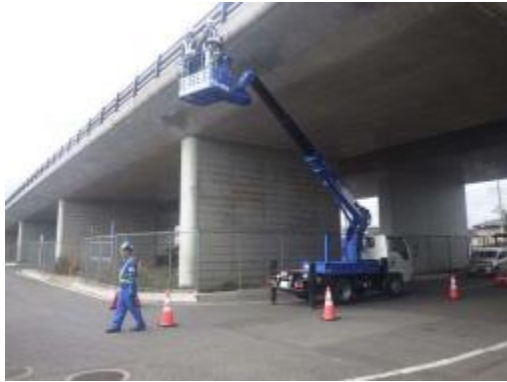
写真 3-1-1 定期点検のイメージ (高所作業車)
