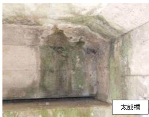
写真 3-3-32 漏水・遊離石灰
