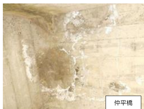
写真 3-3-18 漏水・遊離石灰
