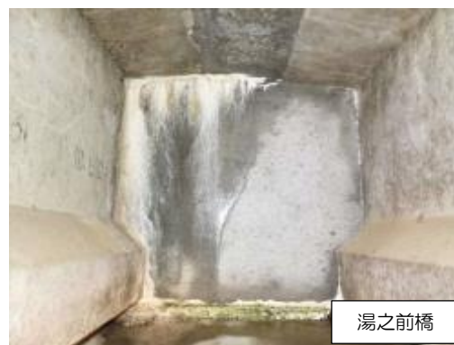
写真 3-3-34 漏水・遊離石灰
