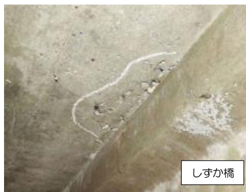
写真 3-3-22 剥離・鉄筋露出(2)
