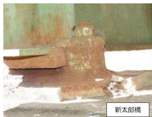
写真 3-3-44 変形・欠損
