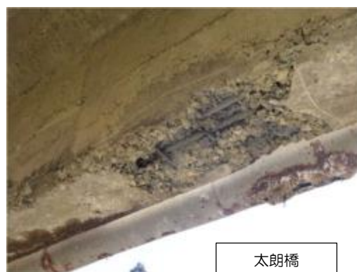
写真 3-3-7 剥離・鉄筋露出(2)
