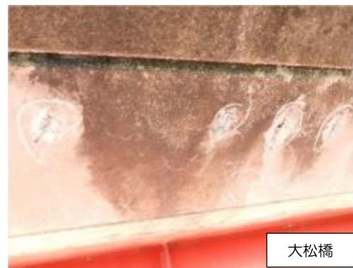
写真 3-3-14 剥離・鉄筋露出
