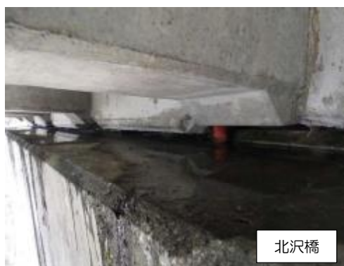
写真 3-3-47 漏水・滞水
