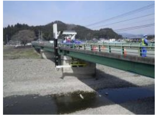
写真 3-1-2 定期点検のイメージ (橋梁点検車)
