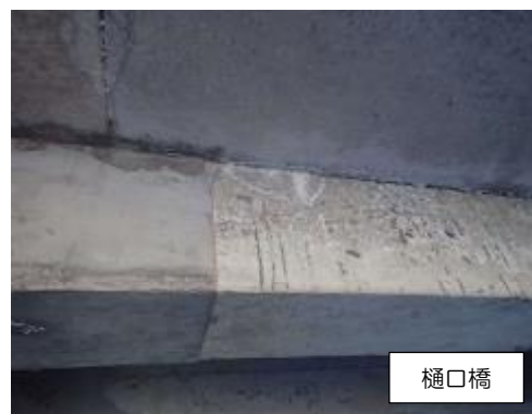
写真 3-3-8 漏水・遊離石灰
