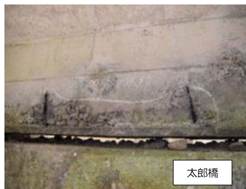
写真 3-3-30 剥離・鉄筋露出(1)
