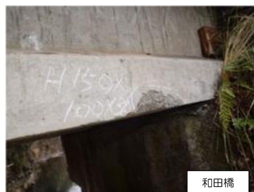
写真 3-3-12 剥離・鉄筋露出(2)
