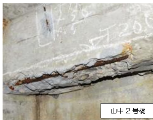
写真 3-3-6 剥離・鉄筋露出(1)
