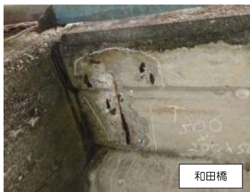
写真 3-3-21 剥離・鉄筋露出(1)
