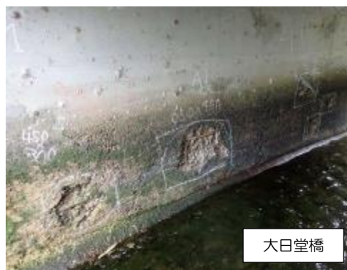
写真 3-3-38 剥離・鉄筋露出
