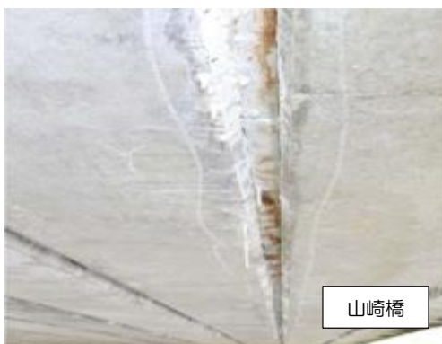
写真 3-3-23 漏水・遊離石灰(1)
