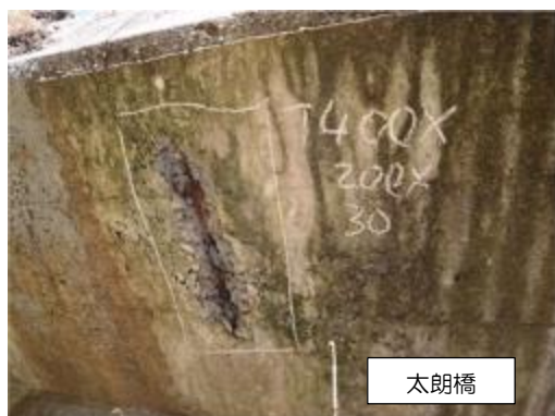
写真 3-3-17 剥離・鉄筋露出
