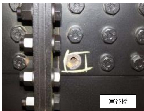
写真 3-3-3 ボルトの脱落
