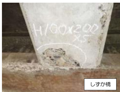
写真 3-3-33 剥離・鉄筋露出
