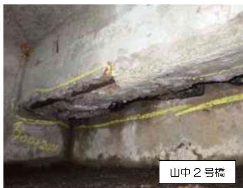
写真 3-3-31 剥離・鉄筋露出(2)
