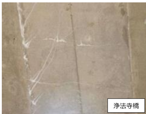
写真 3-3-24 漏水・遊離石灰(2)
