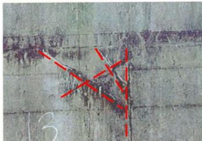
写真2.10 ブロック化したひび割れの例
