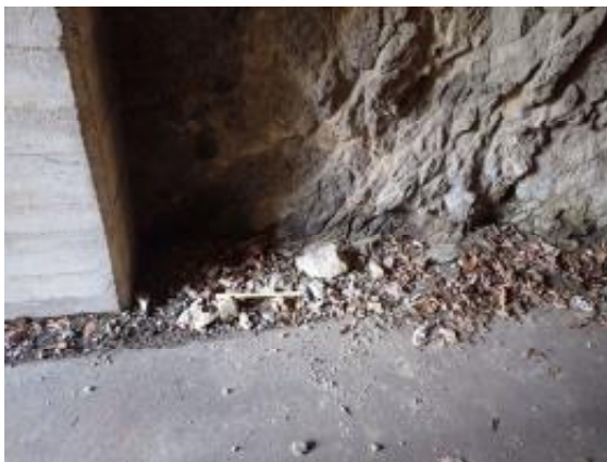
点検ハンマーの小打撃で剥離する岩片
