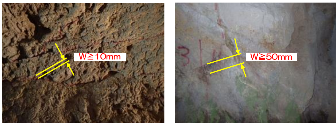
仁中隧道一般部岩盤亀裂の状況
