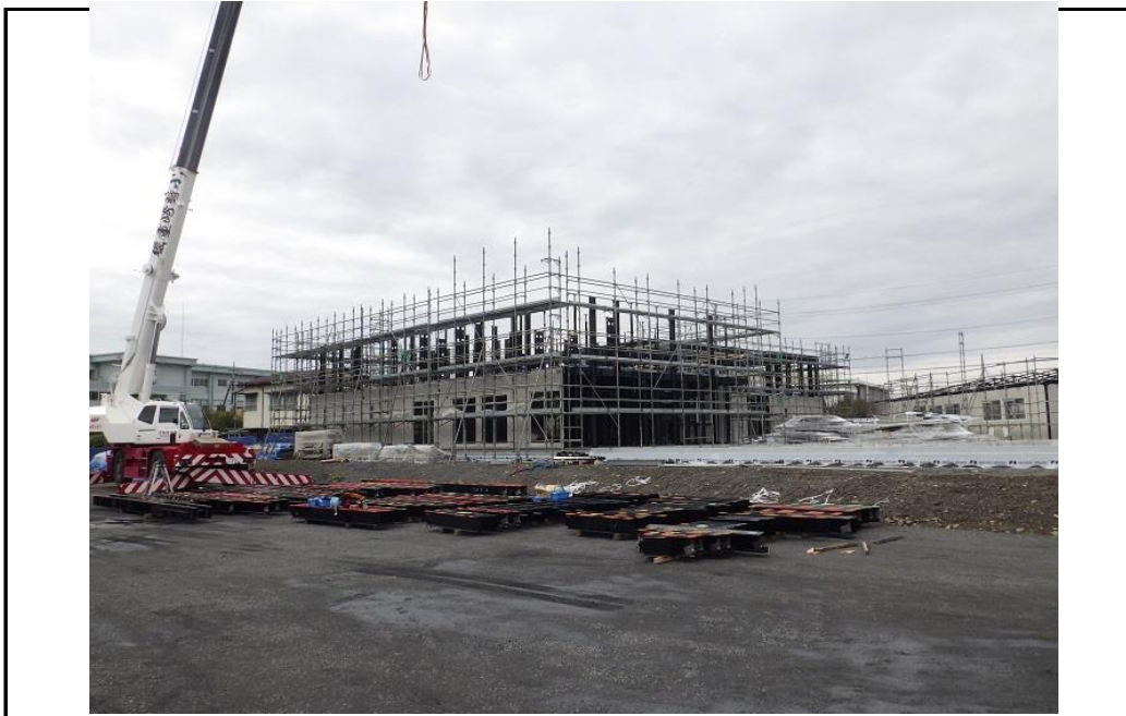
1階部分の外壁が施工され、2階部分の工事が始まっています
