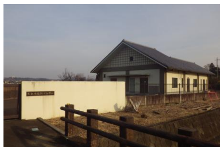
三輪水処理センター
