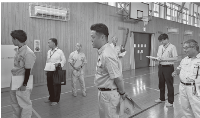
小川中学校体育館の空調設備
