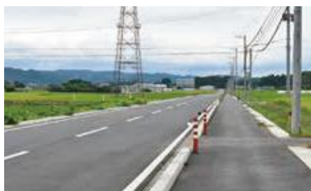
白久から小川市街地を南北につなぐ町道76号線
